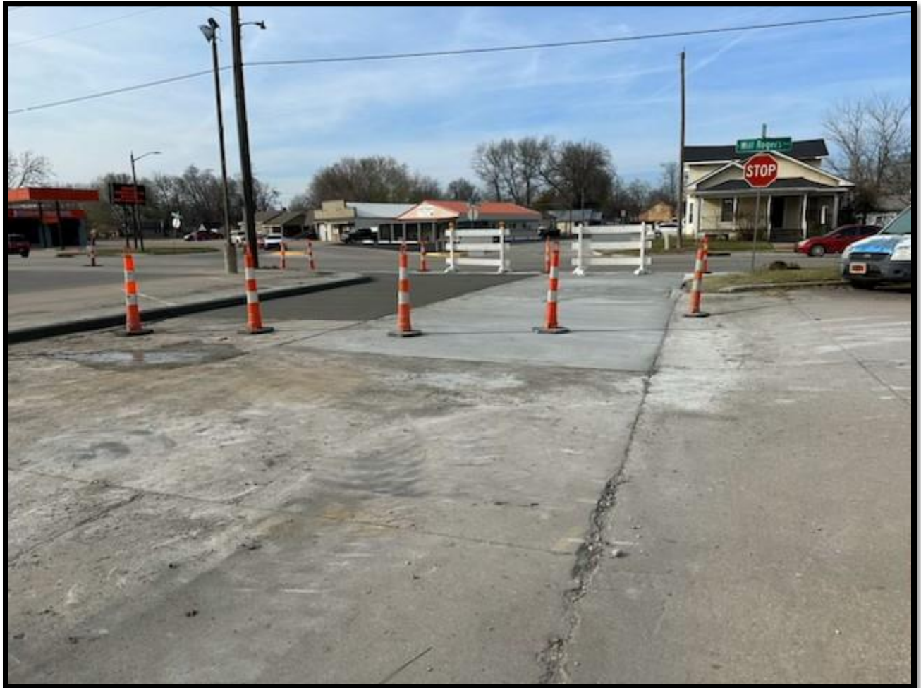
Road Repair on Nome Ave.
